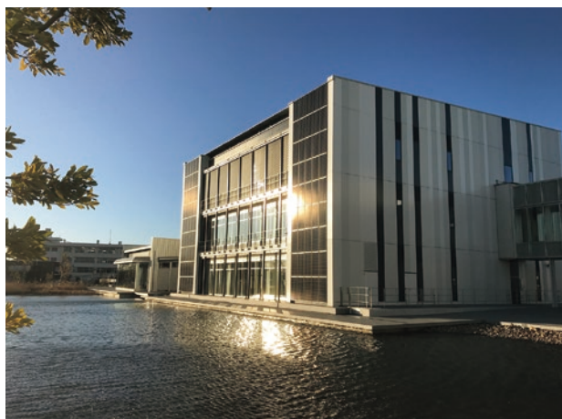
ICI LAB エクスチェンジ棟
