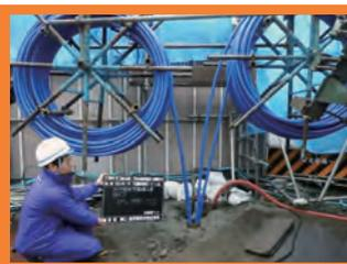
地中熱交換パイプ(Uチューブ)を掘削孔に差し込みます
