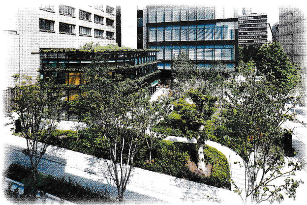
▲緑に囲まれた環境コミュニケーションスペース ECOM 駿河台
